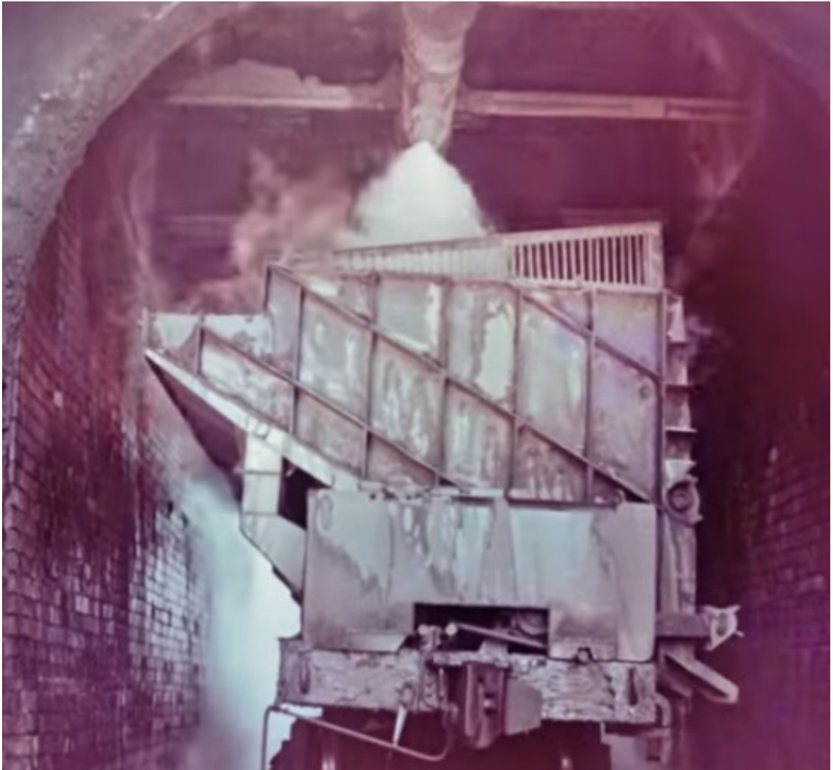
Рисунок 1.3 – Процес тушіння коксу у коксовому вагоні
