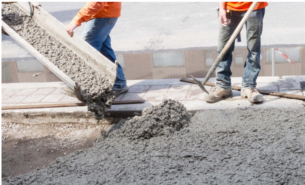
Рисунок 3.2 – Виконання будівельних робіт
