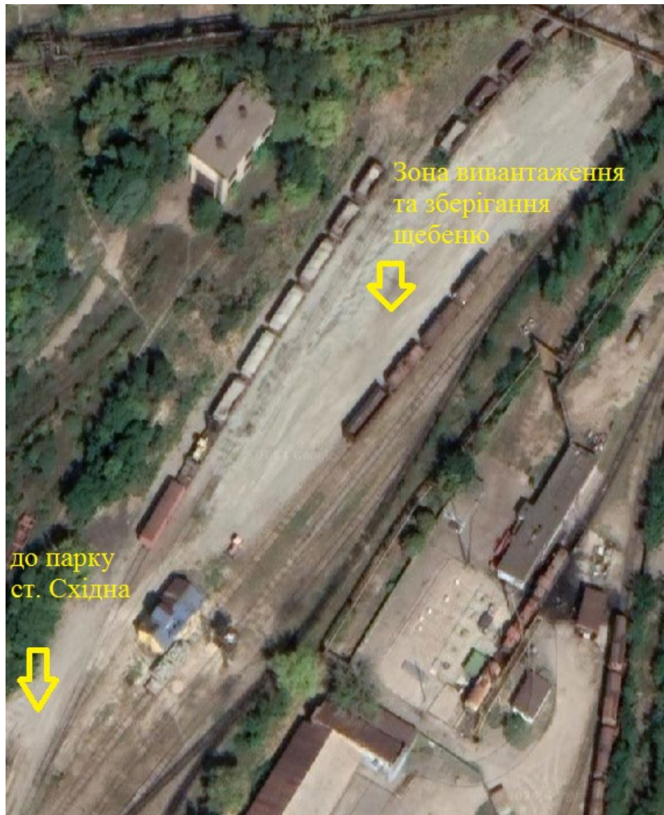
Рисунок 1.8 - Ділянка для вивантаження щебня ЦПУіРК на станції Східна
