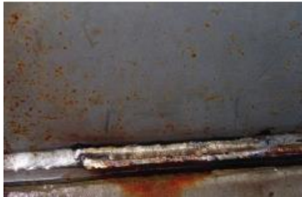
Рисунок 3.14 – Відсутність сплавлення у зварних швах, що може спричинити корозійну атаку [3]
