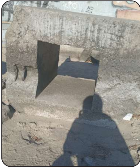
■ Фундамент будинку. Фото авторки
