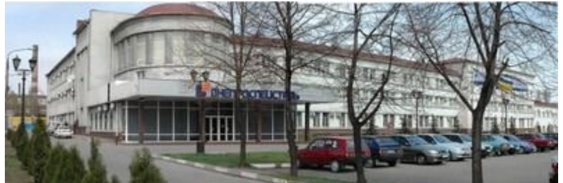
Рисунок 1.1 – Будівля заводу управління ПрАТ «Дніпроспецсталь»
