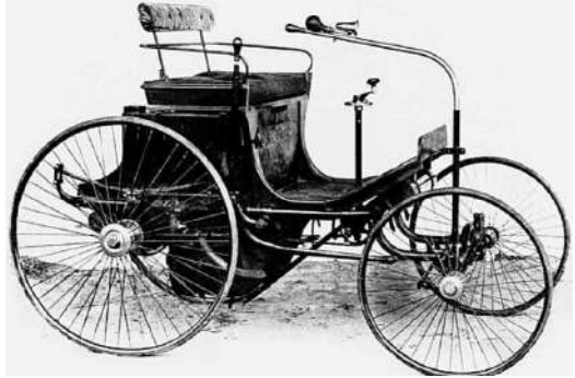
автомобіль Peugeot Type 2 (1890 р.) – перша модель із двоциліндровим чотиритактним бензиновим двигуном Даймлера, зроблена для продажу
