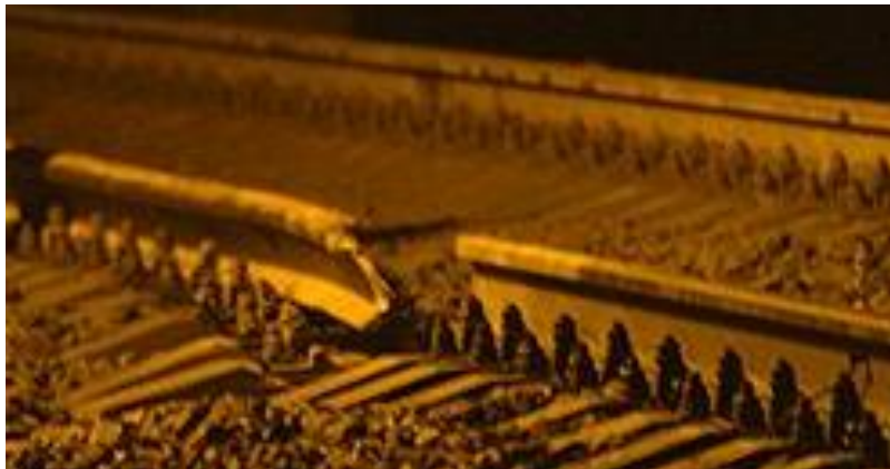
Рисунок 1.1 – Викидання колії безстикової температурно - напруженої конструкції
