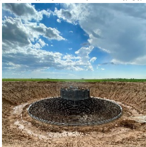
Рисунок 2 – Приклад монолітного з/б фундаменту.
