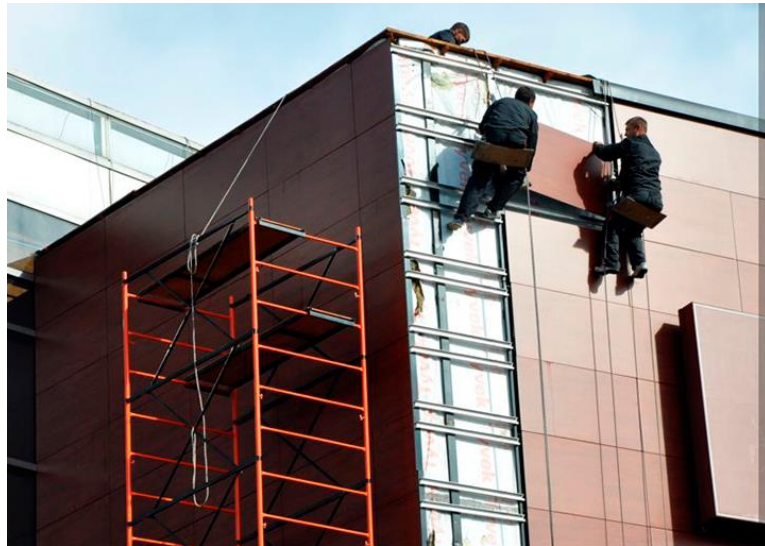
Рисунок 1.15 - Фасад будівлі з алюмінієвих композитних панелей
