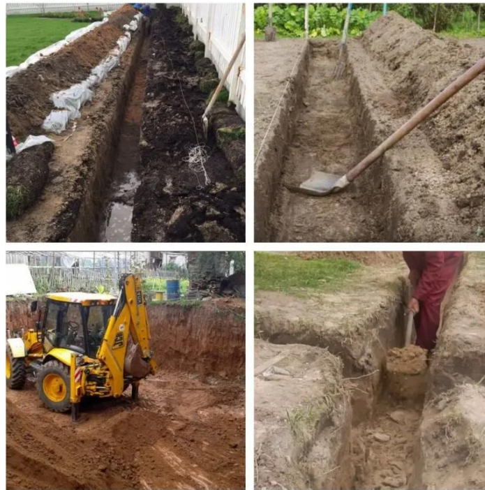
Рисунок 5.2 – Варіанти риття траншей
