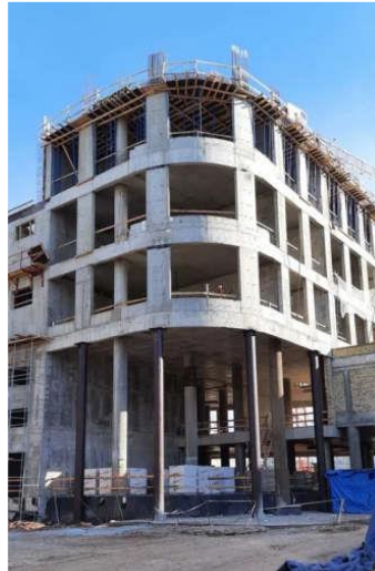
Рисунок 3.16 - Тимчасові підтримуючі конструкції
