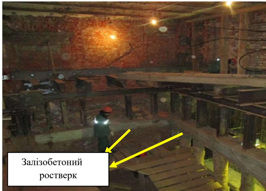
Рисунок 4.4 – Пристрій ростверків
