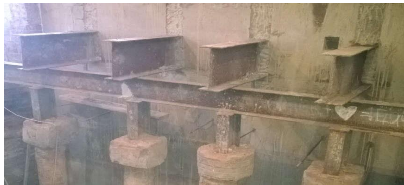
Рисунок 4.5 – Влаштування поперечних балок
