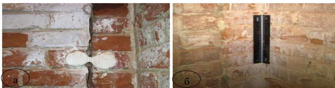
Рисунок 4.1 – Встановлення маяків: а) маяк М10; б) кутовий маяк
