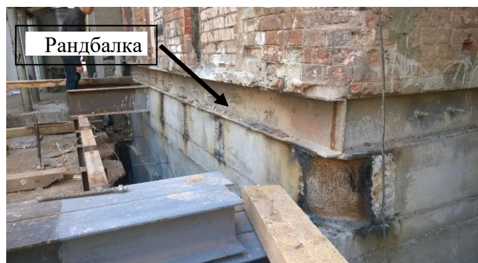
Рисунок 4.2 – Влаштування рандбалки
