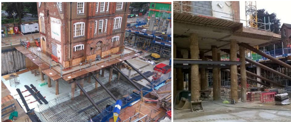
Рисунок 1.7 – Центральна частина Acland House, розташована на плиті розподілу навантаження, Оксфорд
