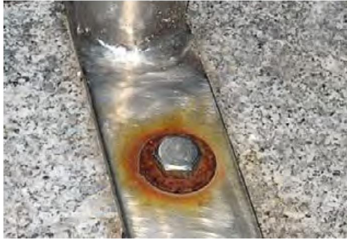
Рисунок 5.16 – Стандартний випадок контактної корозії [13]
