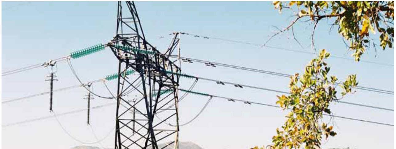
Рисунок 5.3 – Встановлення ОПН підвісного типу на лінійних проводах повітряної ЛЕП
