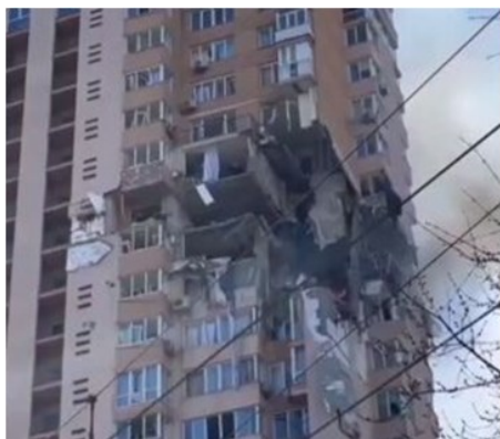
Рисунок 1 – Пошкодження будівельних конструкцій після влучання снаряду
