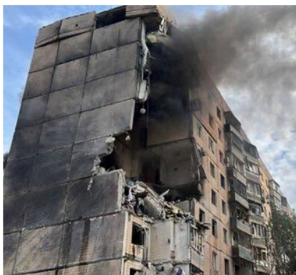
Рисунок 1 – Пошкодження будівельних конструкцій після влучання снаряду
