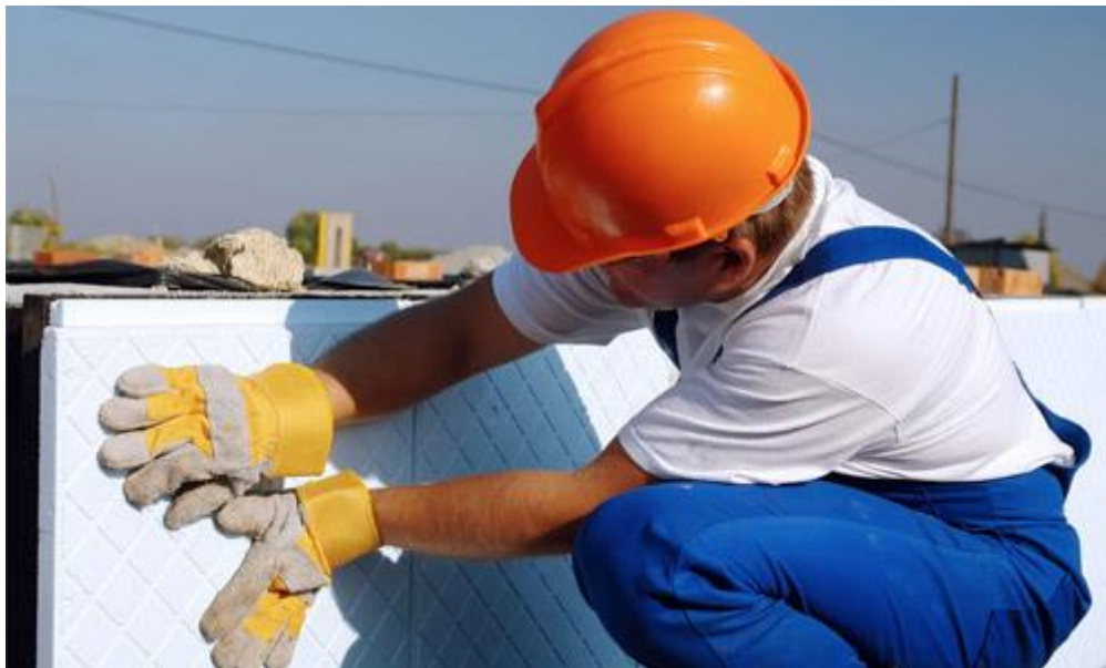
Рисунок 6.59 – Теплоізоляція фундаменту
