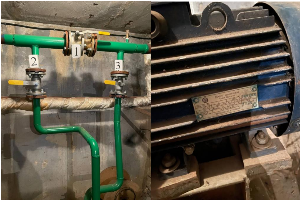
Рисунок 1.16 – Водомірна рамка та двигун
