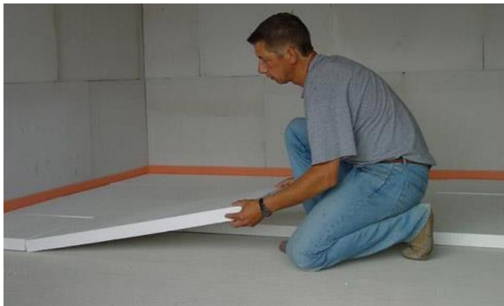
Рисунок 6.58 – Утеплення підлоги пінопластом
