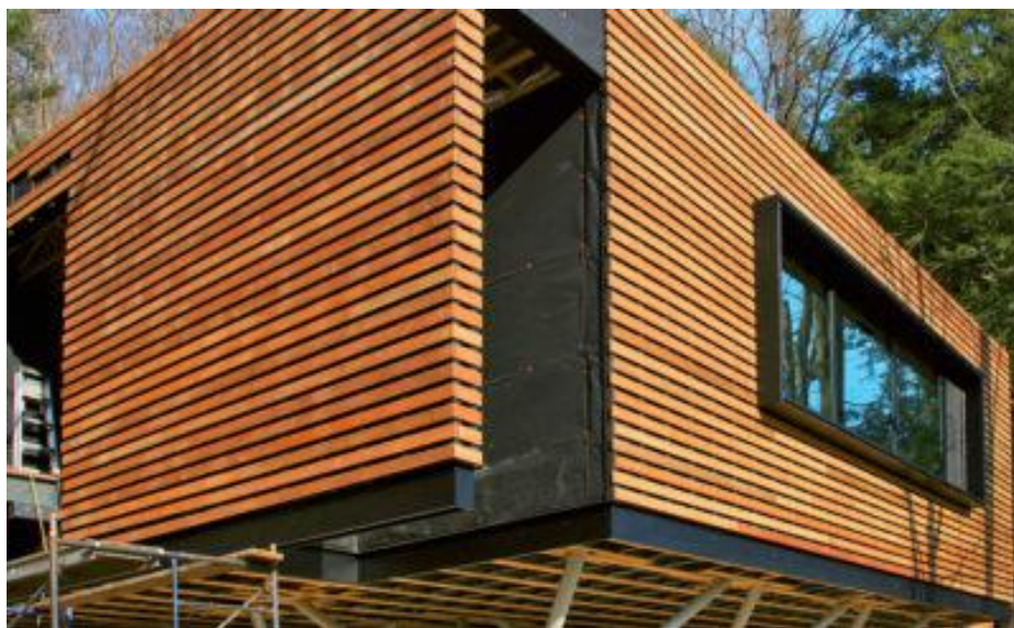
Рисунок 6.36 – Обшивка фасаду деревиною
