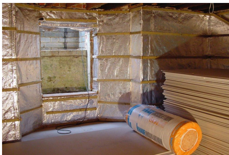
Рисунок 6.55 – Утеплення підвалу
