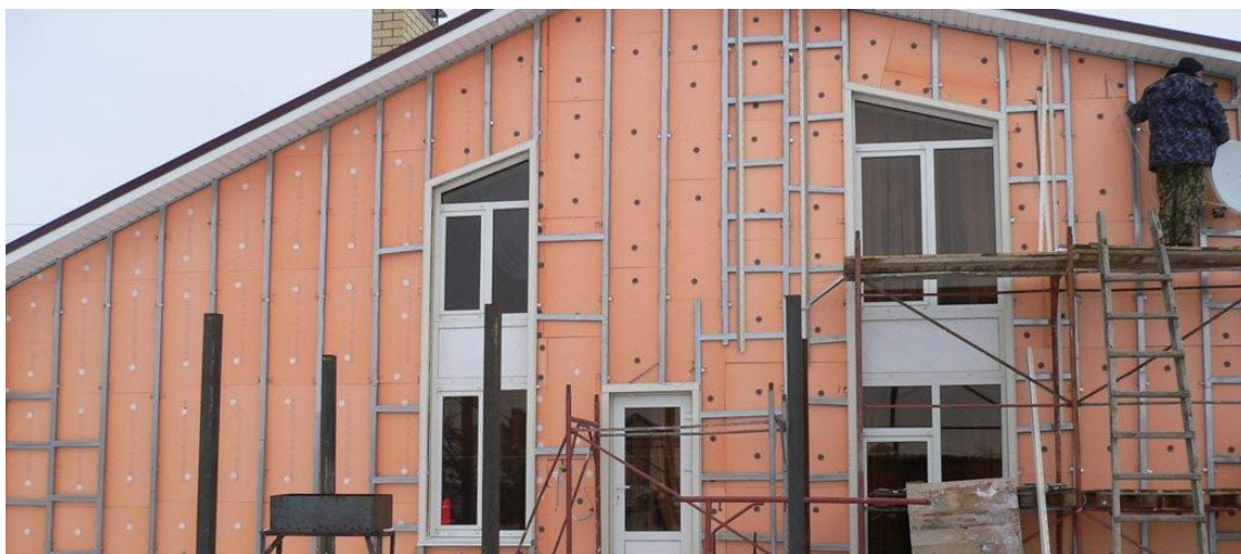
Рисунок 6.45 – Монтаж пінополістиролу
