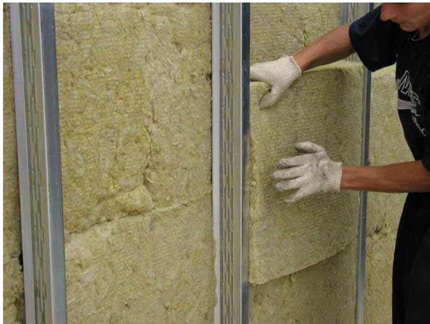
Рисунок 6.51 – Утеплення стін ватою
