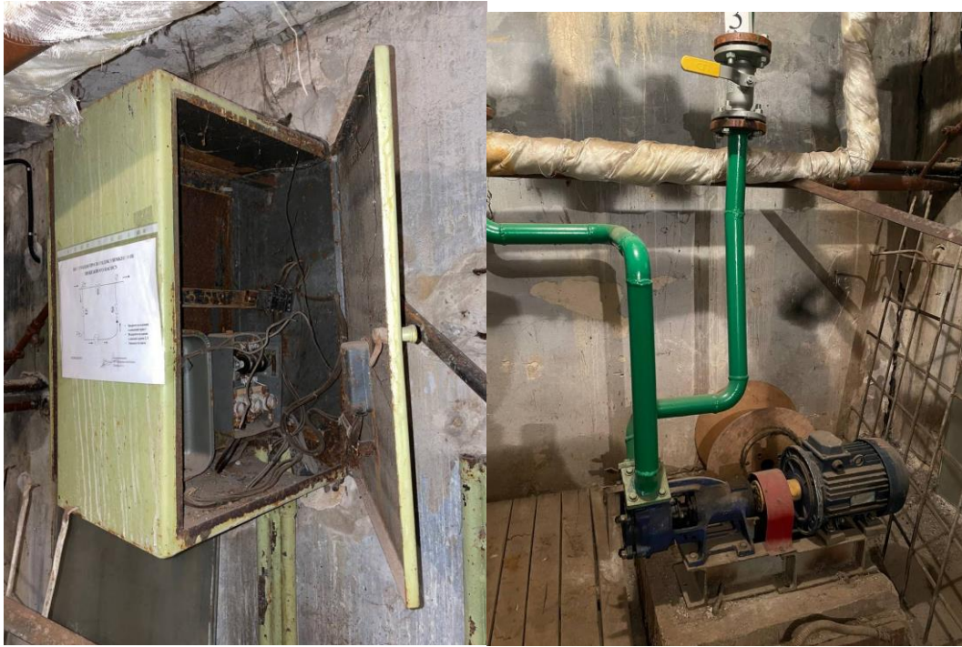
Рисунок 1.17 – Щиток для управління пожежним двигуном
