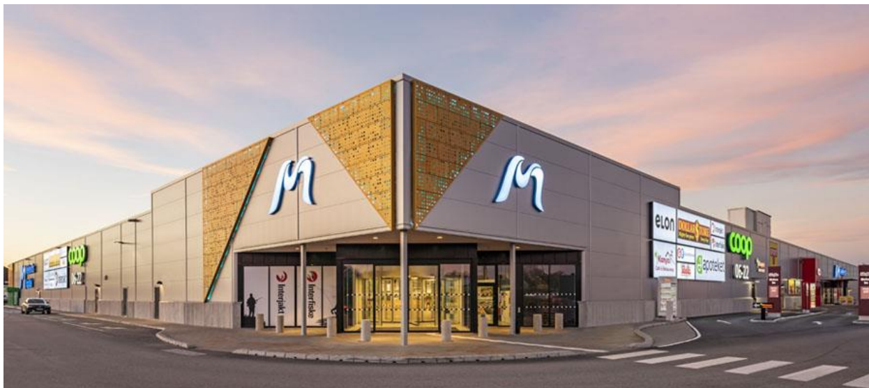
Рисунок 6.15 – ТЦ Melleruds, Швеція. Перфоровані фасадні касети та сендвіч-панелі.
