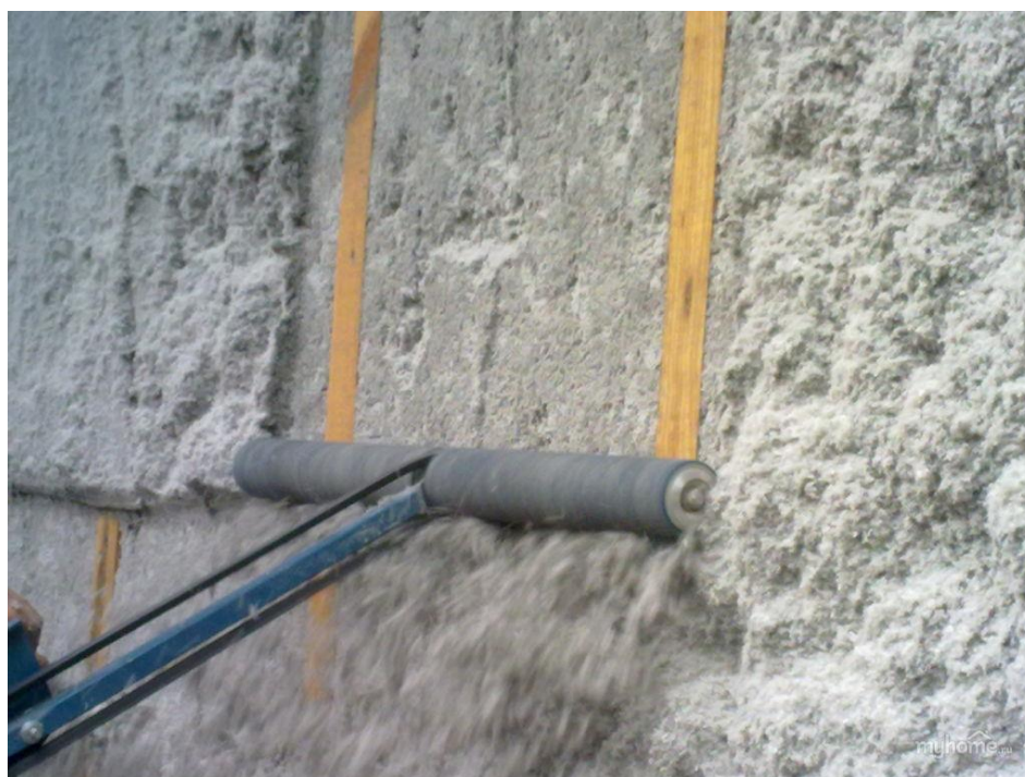
Рисунок 6.8 – Нанесення машинної штукатурки
