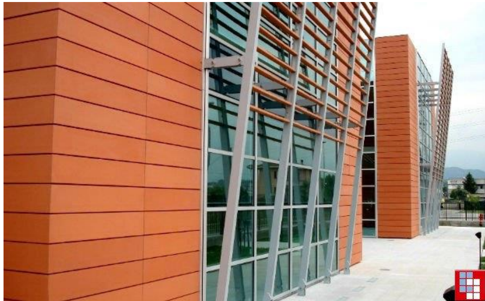
Рисунок 6.29 – Навісний фасад з теракоти
