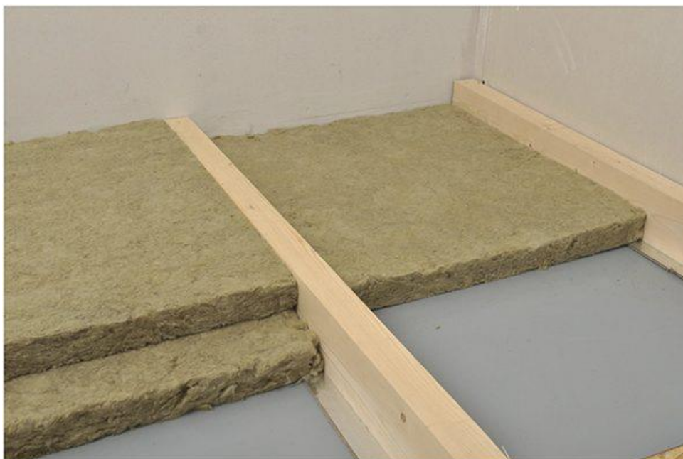
Рисунок 6.56 – Утеплення підлоги
