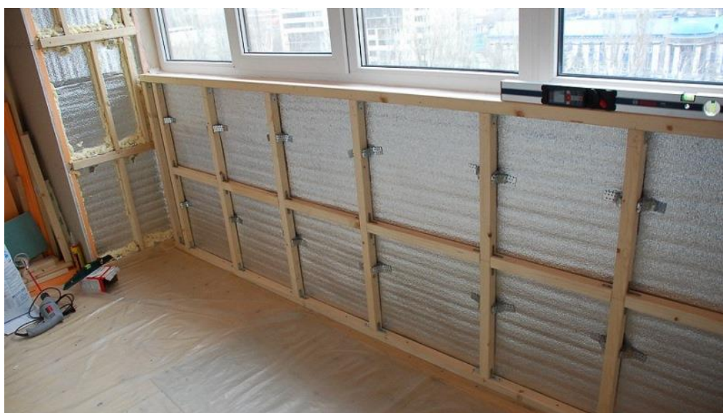
Рисунок 6.41 – Монтаж балконів з використанням вагонки
