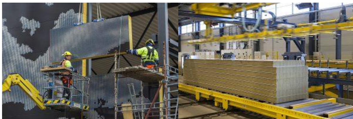
Рисунок 6.23 - Монтаж сендвіч-панелей
