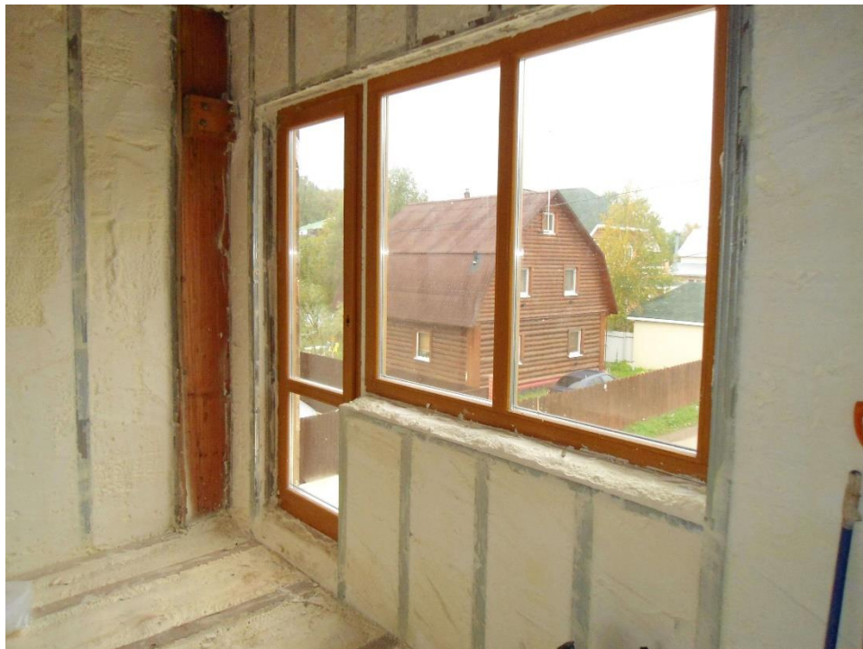
Рисунок 6.2 – Внутрішнє утеплення стін
