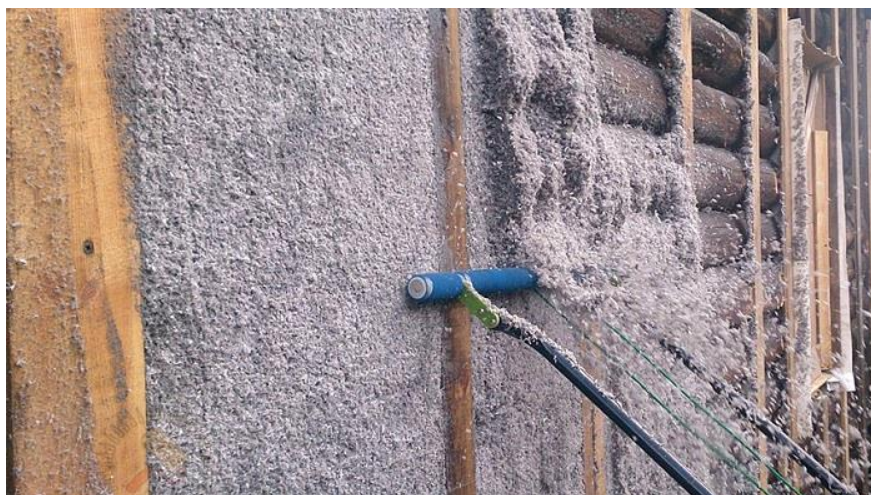
Рисунок 6.11 – Розпилення ековати на дерев'яний дім
