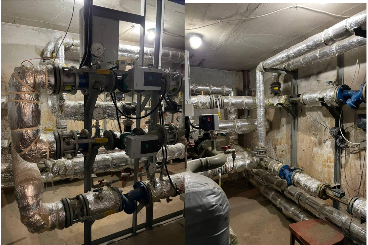
Рисунок 1.15 – Домовий бойлер для подачі ГВС
