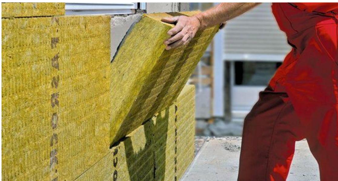
Рисунок 6.3 – Утеплення фасаду кам'яною ватою
