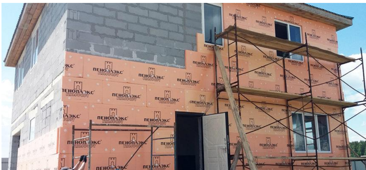
Рисунок 6.44 – Утеплення пінополістиролом
