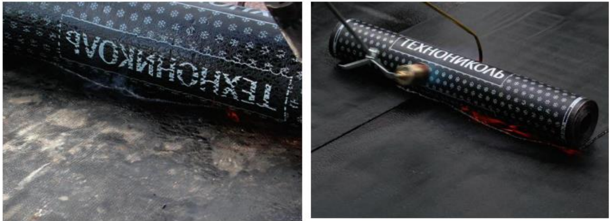
Рисунок 3.19 - Валик розплавленого бітумно-полімерного в'язучого
