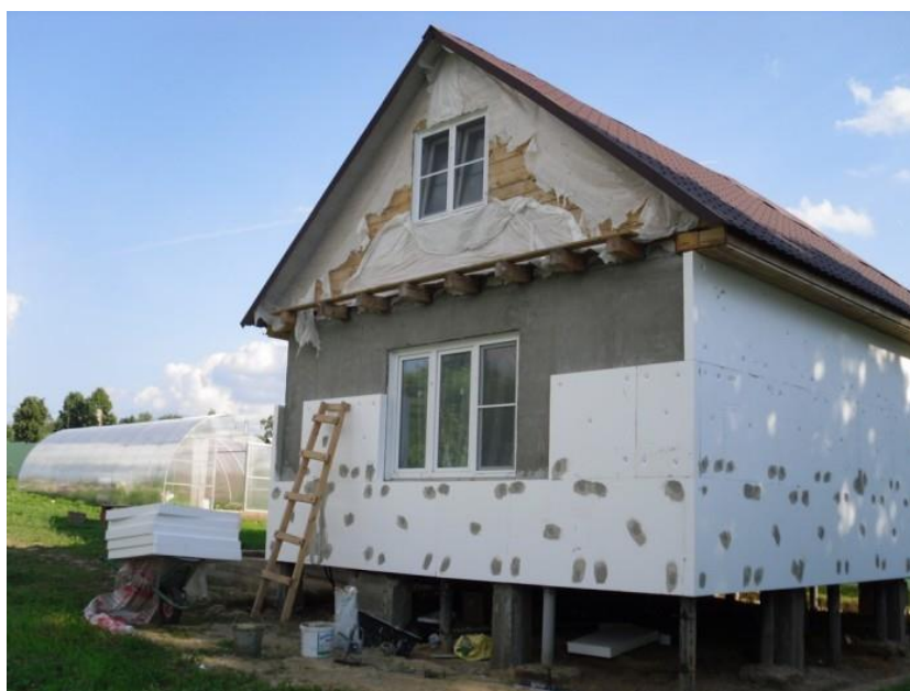
Рисунок 6.1 – Монтаж теплоізоляції на основі пінополістиролу
