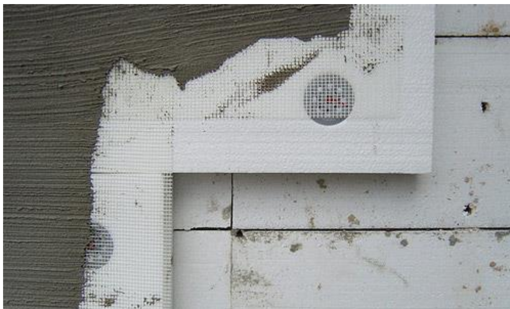
Рисунок 6.57 - Утеплення стін зовні пінопластом
