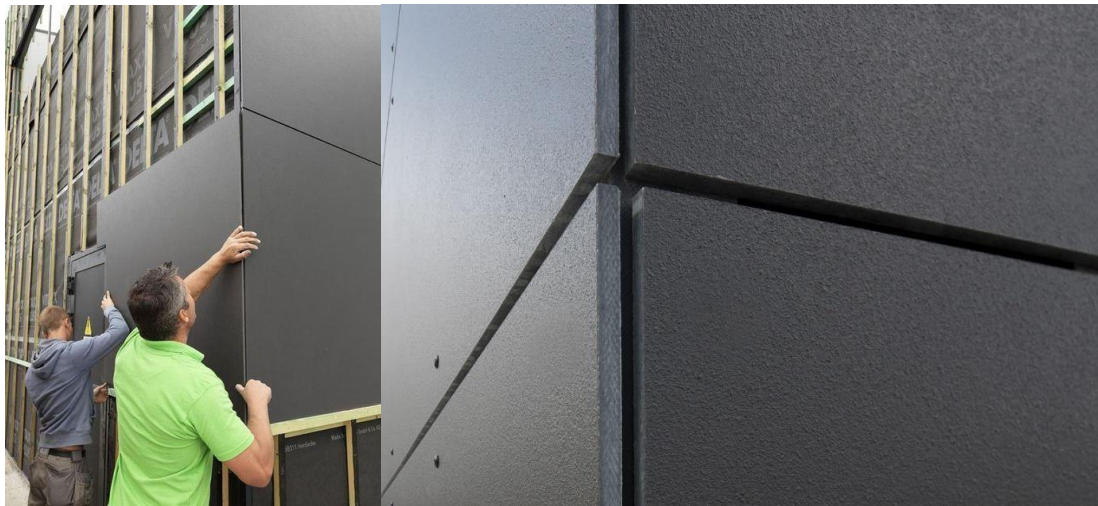
Рисунок 6.16 – Монтаж фіброцементних плит
