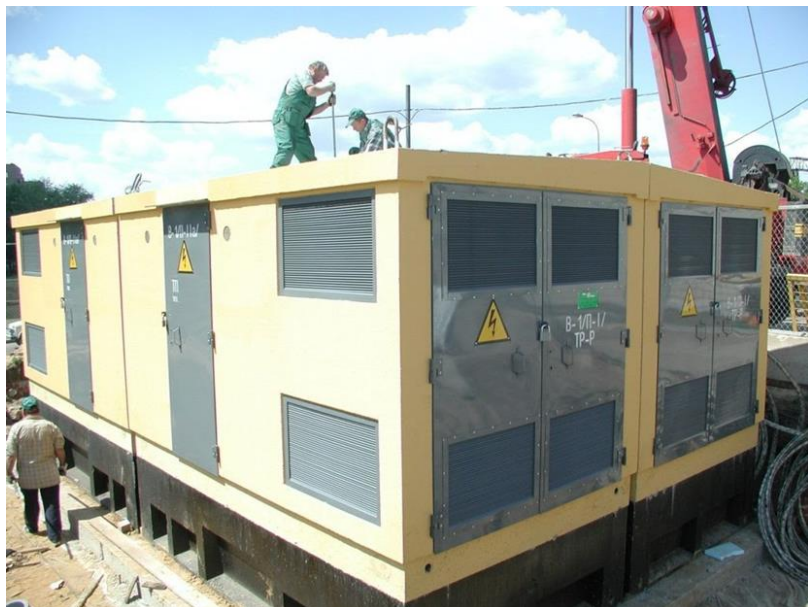
Рисунок 4.1 – Встановлення окремої будівлі для підстанції
