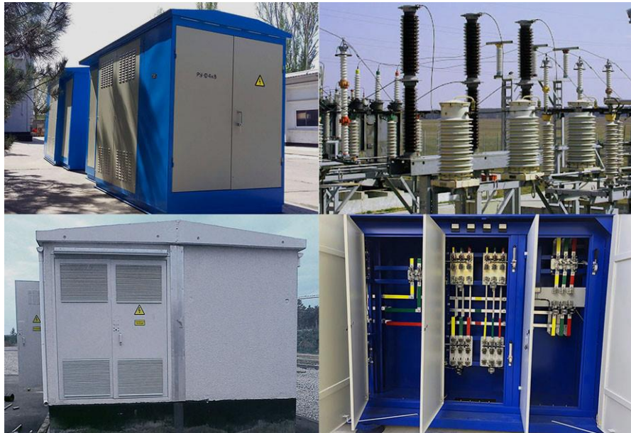
Рисунок 4.3 – Комплектна трансформаторна підстанція (КТП)
