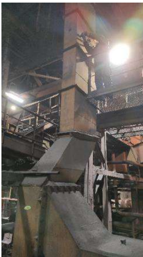
Рисунок 2.10– Розташування місця проведення вимірювань на повітропроводі вентилятора головного провітрювання
