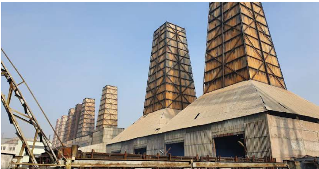
Рисунок 1.4 – Реконструйовані газоочисні установки ПрАТ Запоріжжяабразив
