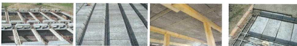
Рисунок 3.6 - Посилення перекриттів і забезпечення надійної теплоізоляції похилих стін і даху
