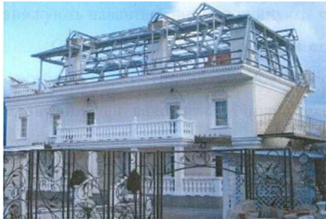
Рисунок 3.3 - Легкі сталеві тонкостінні конструкції мансард
