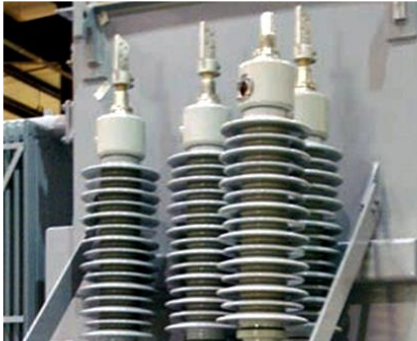
Рисунок 3.5 – Конструкція вводу з твердою ізоляцією [9]
