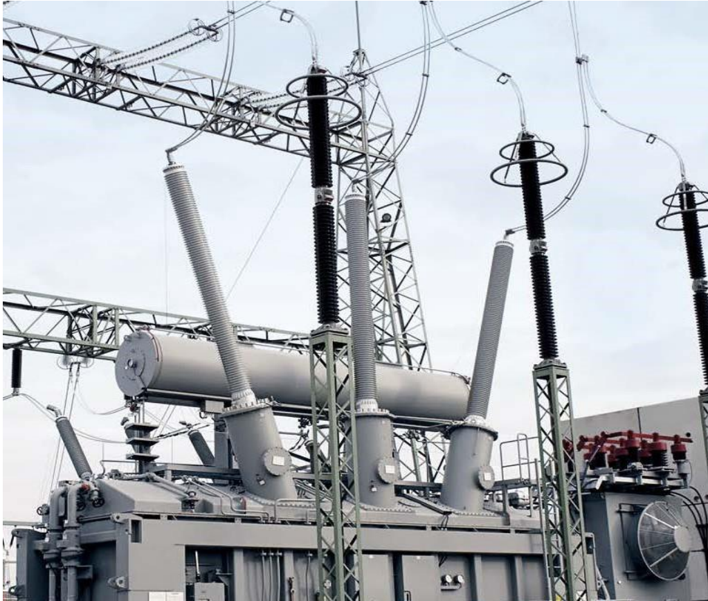
Рисунок 1.4 – Високовольтні вводи для трансформаторів STARIP®+/STARIP®-Si+ з RIP-ізоляцією виробництва HSP HOCHSPAN- NUNGSGERATE GMBH (Німеччина) напругою від 24 кВ до 800 кВ зі стру- мом до 6000 А [2, 3, 4]
