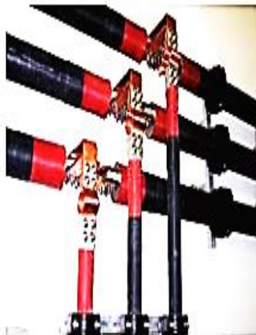
Рисунок 10.7 – Приклад установки трансформаторів струму ( a ) та відпайок ( б )
