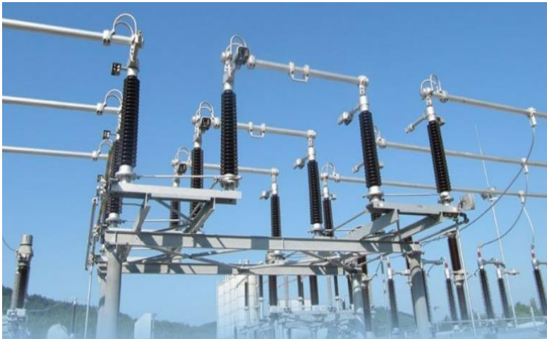
Рисунок 7.1 – Ділянка лінії з високовольтними роз'єднувачами
