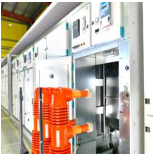
Рисунок 9.5 – Елемент викочування КРП
