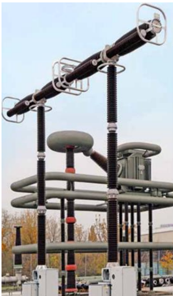
Рисунок 5.5 – Конструкції подвійних концентричних екранів
