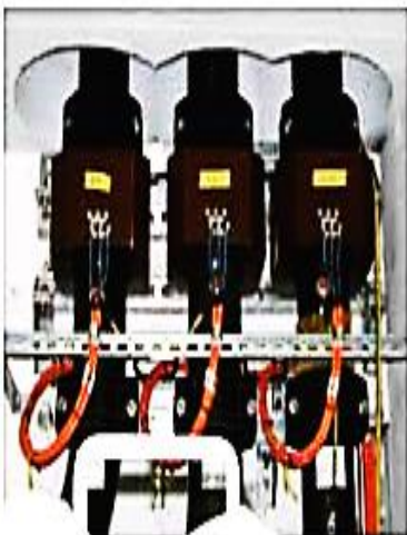
Рисунок 10.7 – Приклад установки трансформаторів струму ( a ) та відпайок ( б )
