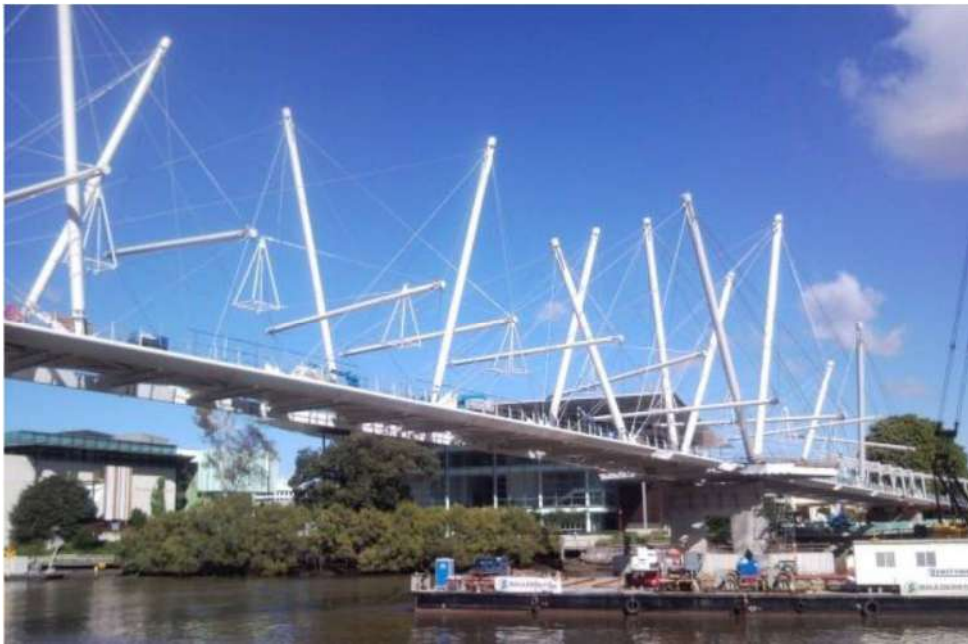
Рисунок 5.2 Міст Курилпа Брідж (Брісбен, Австралія), виконаний за системою «тенсегріті»
