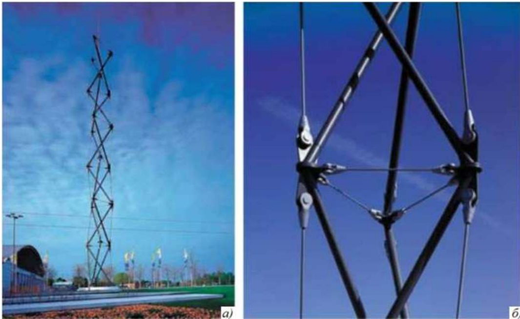
Рисунок 5.7. Башта Уорноу, де: а) загальний вигляд; б) крупний план з'єднання двох Т-подібних призм
