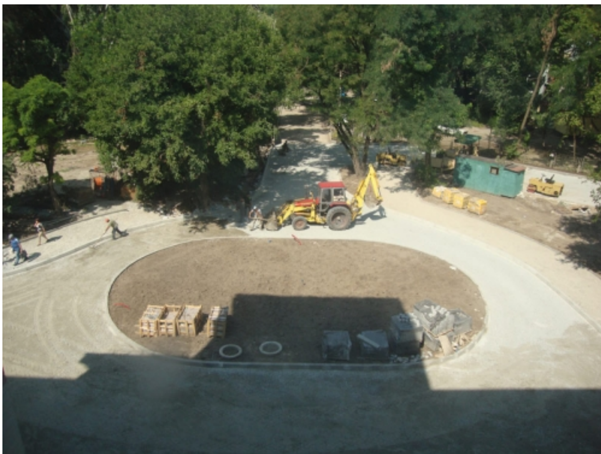
Рисунок 1.2 – Дорожнє будівництво силами ТОВ «МБК»
