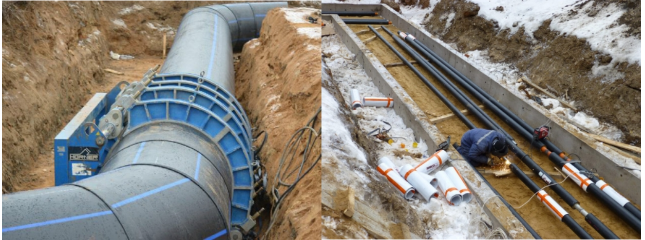
Рисунок 1.3 – Будівництво інженерних мереж силами ТОВ «МБК»
