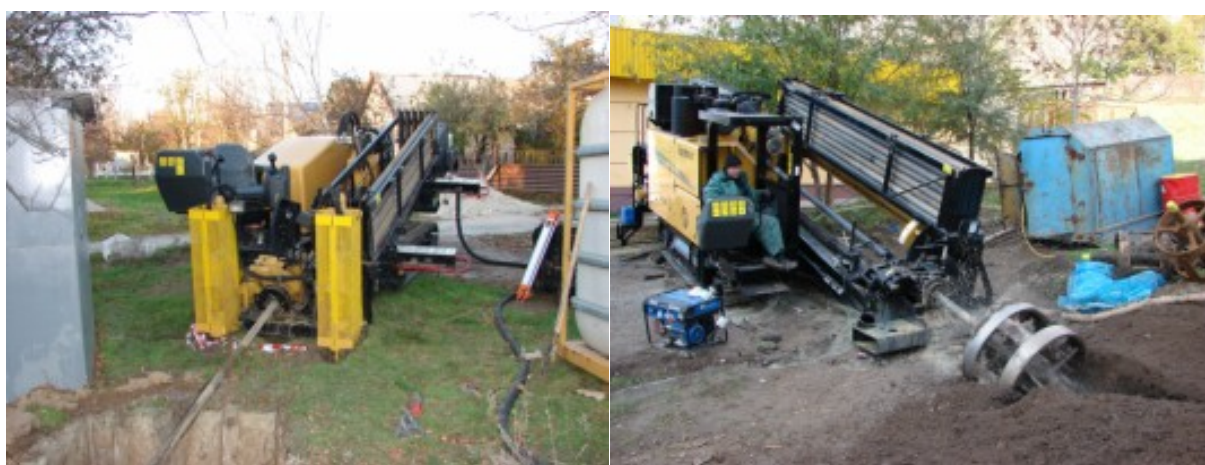
Рисунок 1.5 – Використання обладнання Vermeer Navigator
