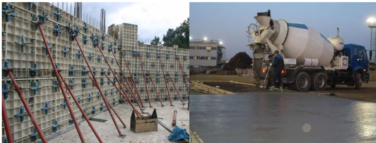
Рисунок 1.4 – Робота з бетонними конструкціями ТОВ «МБК»
