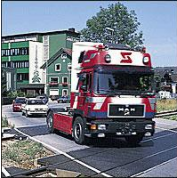
Рисунок 2.2 – Система переїзду з гумовими панелями
