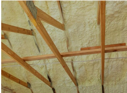
Рисунок 1.14 – Теплоізоляційний матеріал з пінокарбамидно-формальдегідного пінопласту
