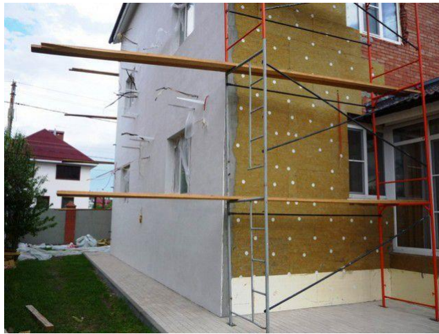
Рисунок 2.1 - Технологія монтажу мокрого фасаду
