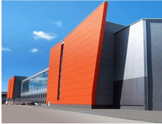
Рисунок 1.29 - Фасад будівлі з алюмінієвих композитних панелей
