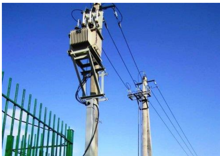
Рисунок 1.1 – Стовпова підстанція[9]
