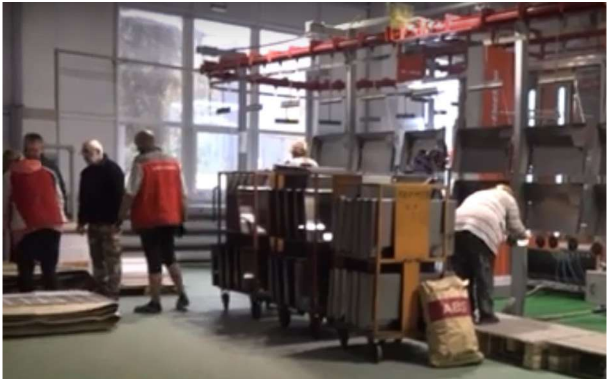
Рисунок 1.2 – Процес виготовлення сталевих елементів
