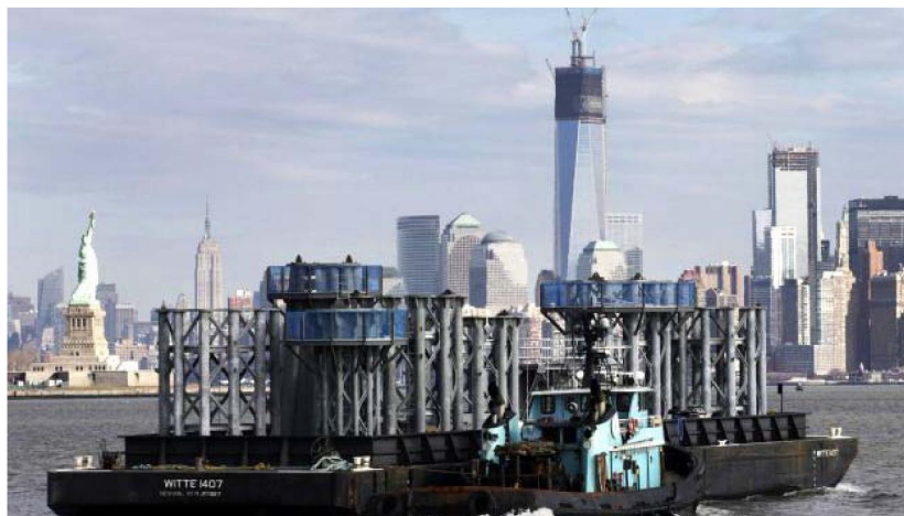
Рис. 4. Подвоз металлических конструкций из аустенитной нержавеющей стали для строительства One World Trade Center в Нью-Йорке
