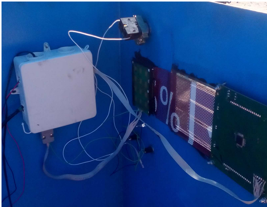
Рисунок 2.21 – Монтаж дисплейної плати, плати керування та клавіатури в корпус колонки (Фото 2)
