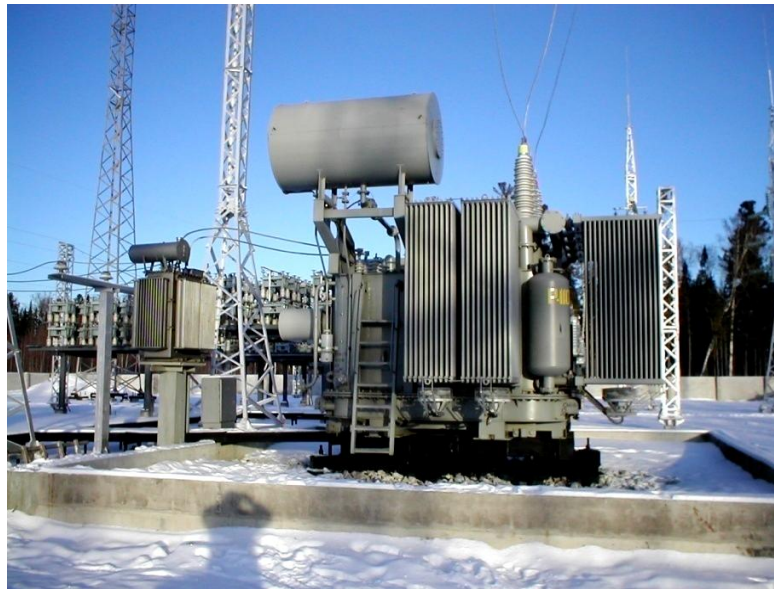
Рисунок 1.3 – Шунтувальний реактор РОМ-60000/500
