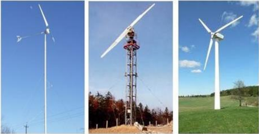
а) однолопатева; б) дволопатева; в) трилопатева; Рисунок. 3.4. - ВЕУ з горизонтальною віссю обертання
