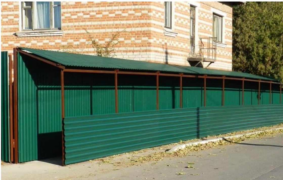
Рисунок 5.1 – Огородження будівельного майданчику з козирком
